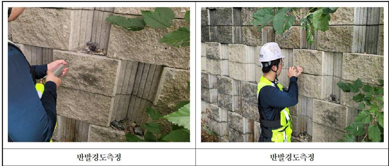
【사진 6.4.1】 재료시험 조사 전경
