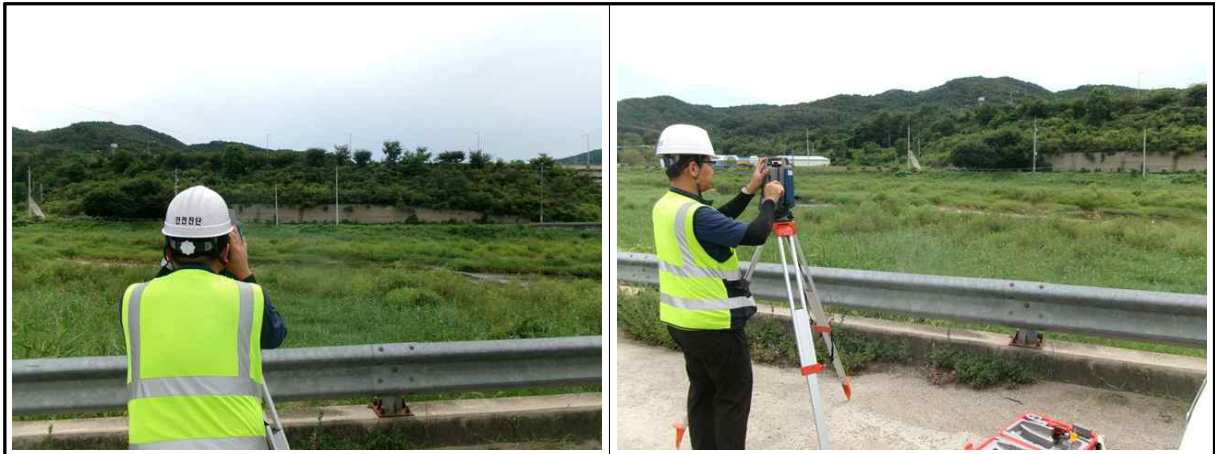
【사진 6.4.2】 측량작업 전경
