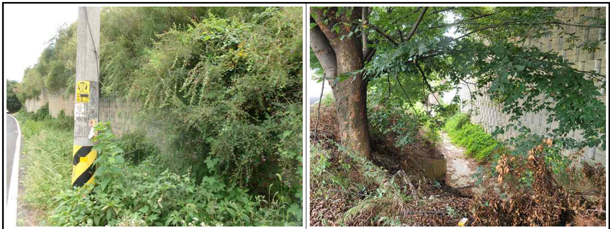
【사진 6.3.1】 지반, 기초부 전경
